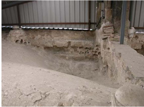
Fig. 4-53. Vaciado del riñón de una bóveda del trascoro.
