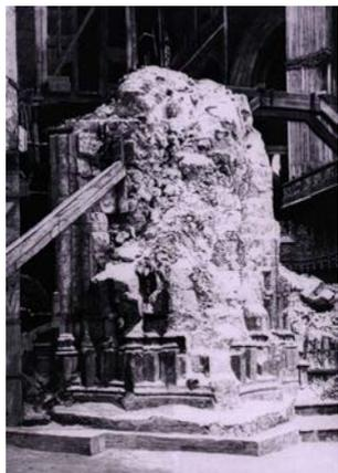
Fig. 4-35. Interior de un pilar del crucero tras el derrumbe de 1888. Catedral de Sevilla. Beuchy.
